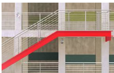
Carpenteria metallica pesante.
